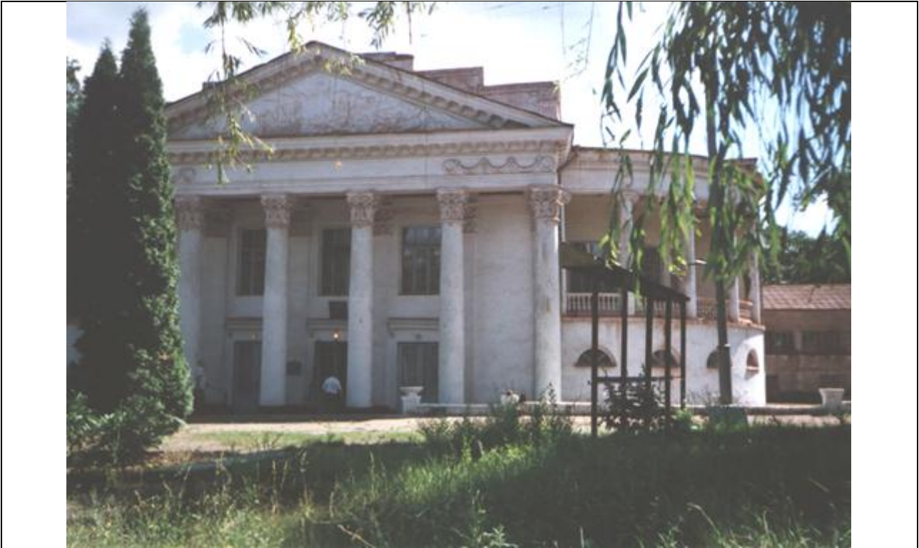
Мал. 3.55 - Загальний вигляд будівлі Свято-Володимирського кафедрального собору по вул. Клубній
