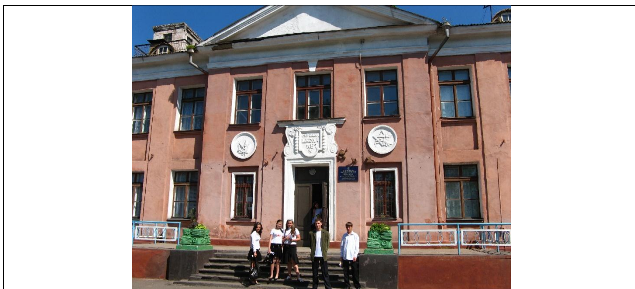
Рисунок 4.2 – Загальний вигляд школи №67 по вул. Переяславській, 6
