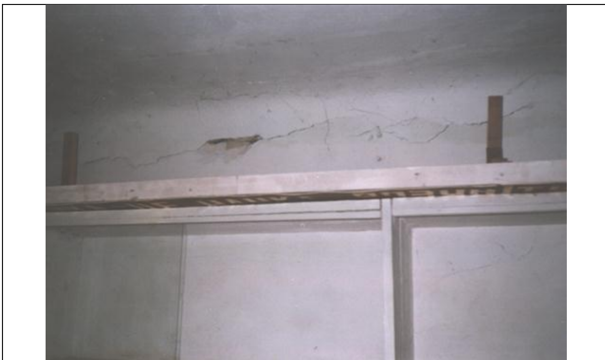
Рис. 3.52 – Горизонтальні тріщини в місці сполучення стіни і стелі в приміщенні школи по вул. Планетарній, 47 в селищі Верабово
