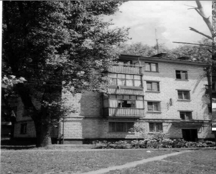
Рис. 3.2. Житловий будинок по вул. Бірюзова, 7, головний фасад.
